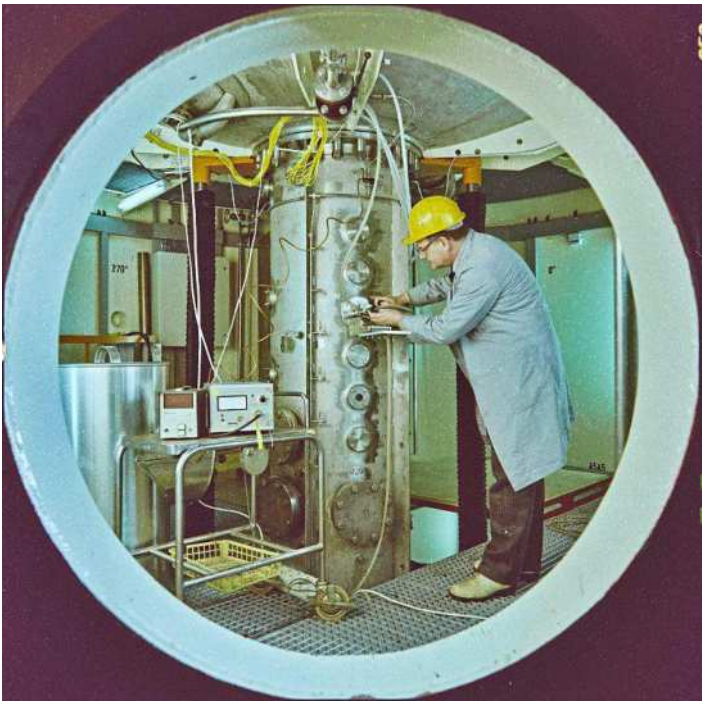
Einblick in die Versuchsanlage CORA: Hier wurden 1986 schwere Kernschäden an Brennstabbindeln untersucht. Foto: KIT-Archiv
